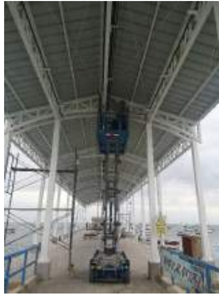
Fotografía 13. Colocación de tuberías conduit central en el cabezo del muelle
