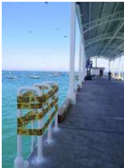
Fotografía 19. Colocación cintas de prevención para proteger el área de las escaleras y forrado con cartón y plástico de los sardineles de madera.
