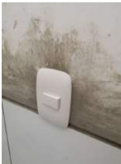
Fotografía 6. Colocación de interruptores
