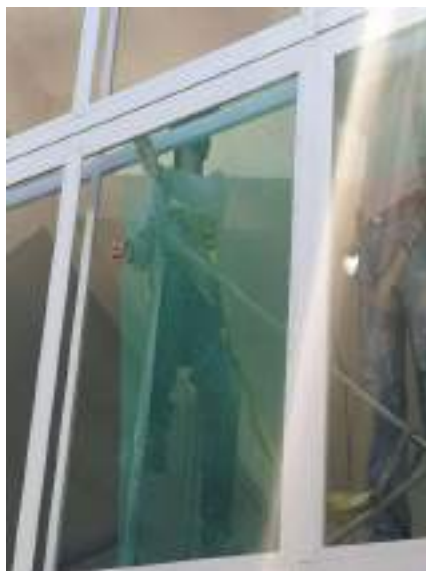
Fotografía 15. Colocación de malla mosquitero en área de tareas previas.
