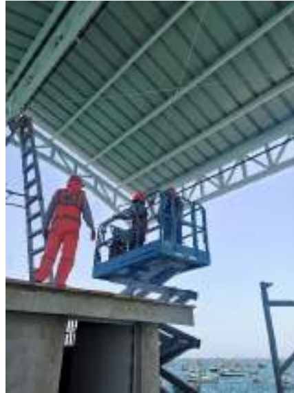
Fotografía 1. Colocación de tubería conduit en el cabezo del muelle
