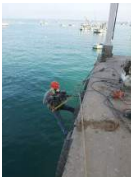
Fotografía 8. Perforación de anclajes para defensas en el cabezo del muelle
