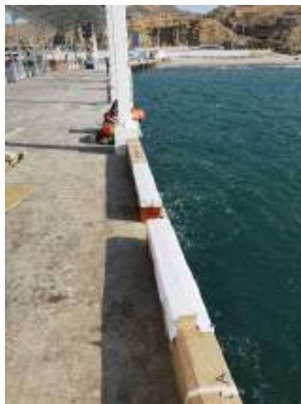
Fotografía 18. Forrado de sardineles de madera para protección con la interperie.
