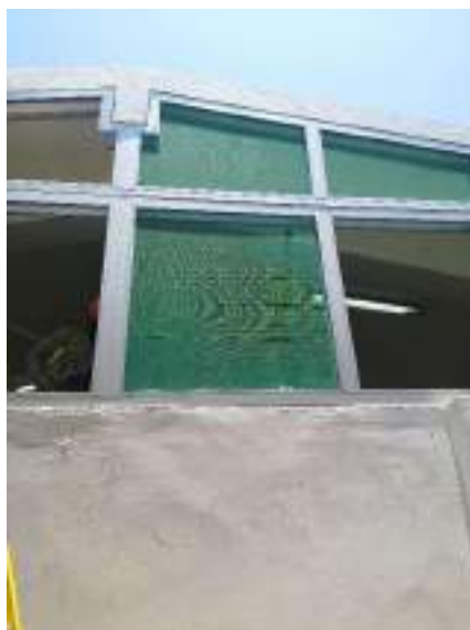
Fotografía 16. Colocación de malla mosquitera exterior
