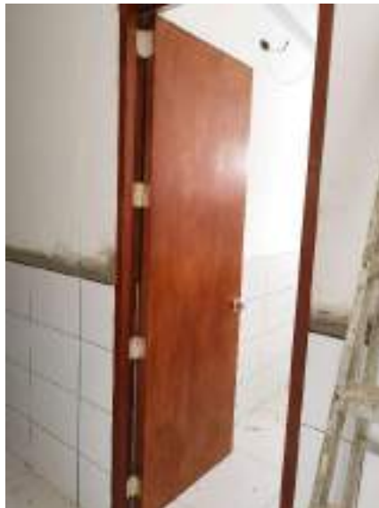
Fotografía 12. Colocación de puertas de madera en área de desinfección.
