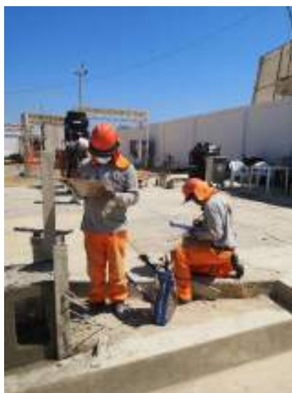
Fotografía 10. Habilitación de caja para caño en radaluvio
