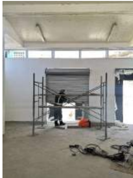
Fotografía 3. Colocación de puertas enrollables
