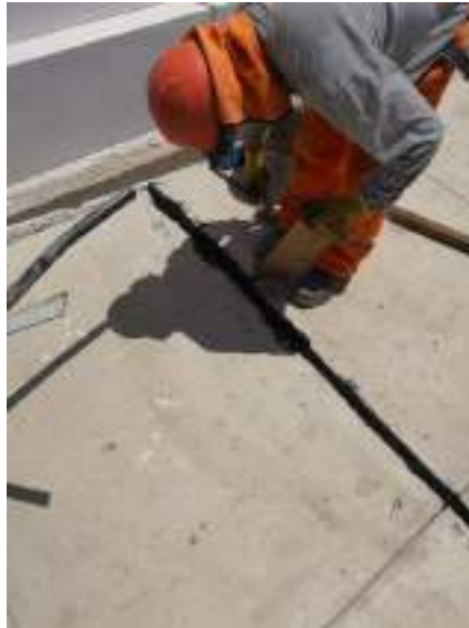
Fotografía 11. Colocación de junta asfáltica.
