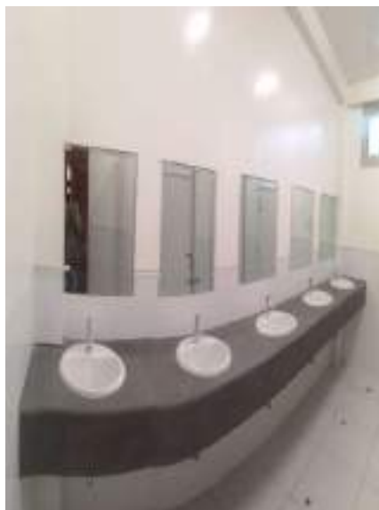
Fotografía 20. Colocación de espejos biselados de 0.60x0.60m, colocación de fibrocemento y colocación de ovalines y grifería en SSHH. MUJERES en el área de desinfección.
