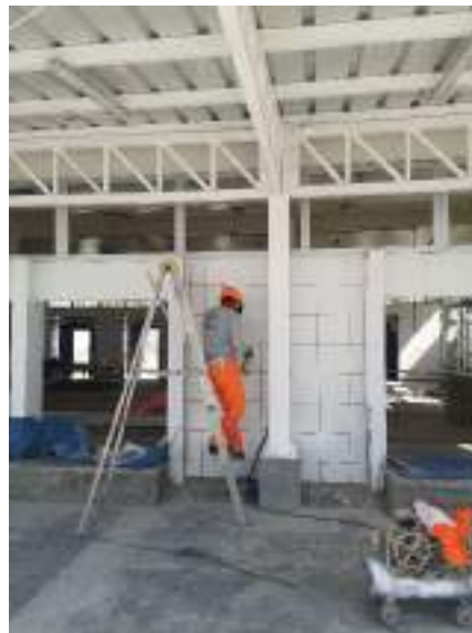
Fotografía 2. Pintado de estructuras metálicas en exteriores de tareas previas
