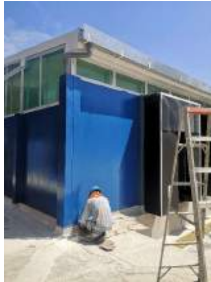
Fotografía 21. Colocación de pintura epóxica color azul noche en la fachada exterior de tareas previas.
