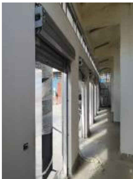
Fotografía 7. Colocación de puertas enrollables.
