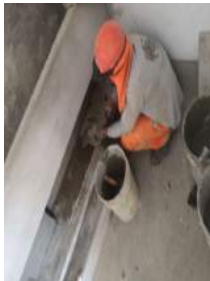
Fotografía 4. Remates en maniluvios en áreas de tareas previas – desinfección.
