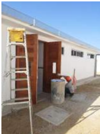
Fotografía 9. Colocación de puertas de madera doble hoja.
