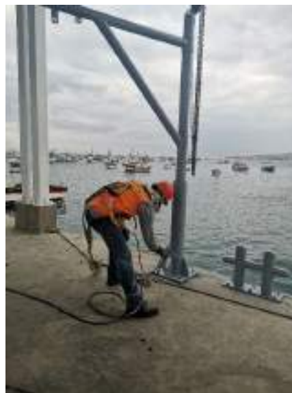
Fotografía 14. Pintado de pescantes en cabezo del muelle
